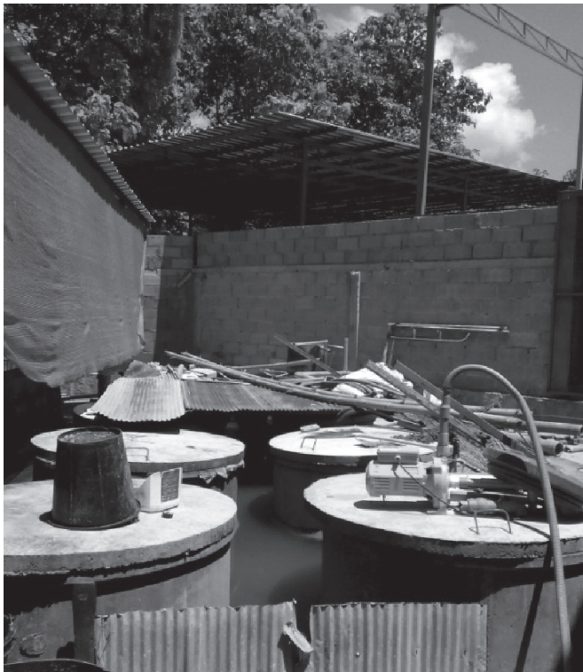
บ่อบำบัดน้ำร้อนจากการกลั่นสุรา ที่บ้าน พร้อมบำบัดด้วยวิธี ธรรมชาติแล้วนำกลับไปใช้ใหม่
